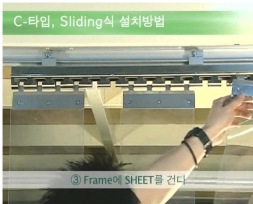
③ Frame에 Sheet를 건다.
