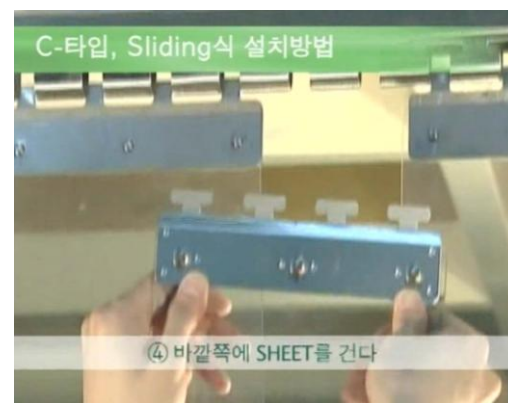
④ 바깥쪽에 Sheet 를 건다. (먼저 거는 행거의 볼트머리부분이 전면에 보이지 않도록 걸 것)
